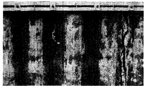
图6 开挖后局部桩间情况
