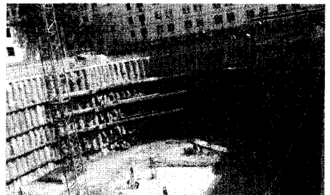
图7 开挖到底后情况
